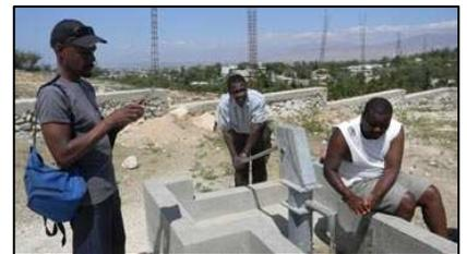
Les fondations semblent correctement faites c'est un libage périphérique, mais par contre les poteaux ancrés dans ces fondations ne sont pas ferrailés pour recevoir un étage supérieur. On a parlé des différentes possibilités de renforcement notamment des contreventements, mais nécessite d'un plan définitif à partir duquel on peut élaborer des plans d'exécutions corrects.
