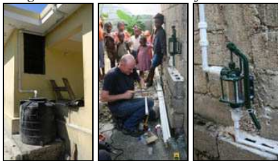
Rénovation du système d'eau
